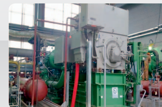
Central eléctrica alimentada por gas - 3000 kW, 6 kV, 4 polos - Protección Ex pex II T3 - Cojinetes con engrase por circulación
